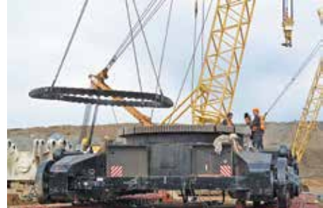
Монтаж экскаваторов отечественного и импортного производства
