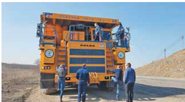
Этап пусконаладочных работ привода КТЭП-90 на автосамосвал БЕЛАЗ в условиях разреза
